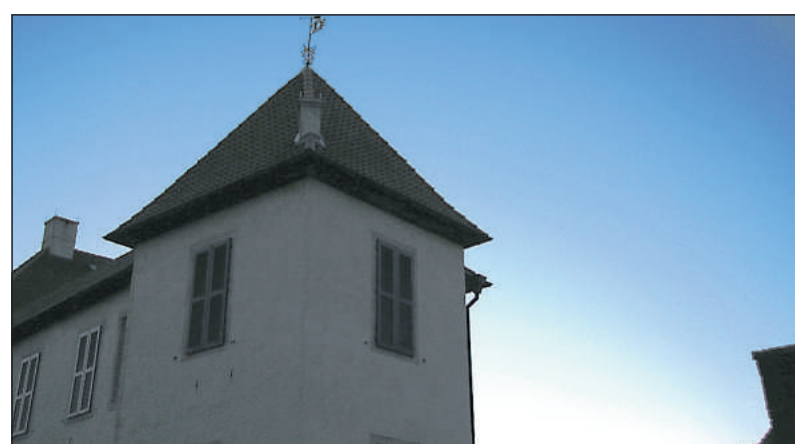
Unter alten Dachziegeln und in rissigen Mauerspalten fühlen sich die Fledermäuse wohl. Sie werden in der Dämmerung aktiv.
