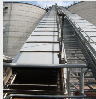
Biomassekraftwerk Förderkettenband mit Mitnehmern aus obo-Festholz®
