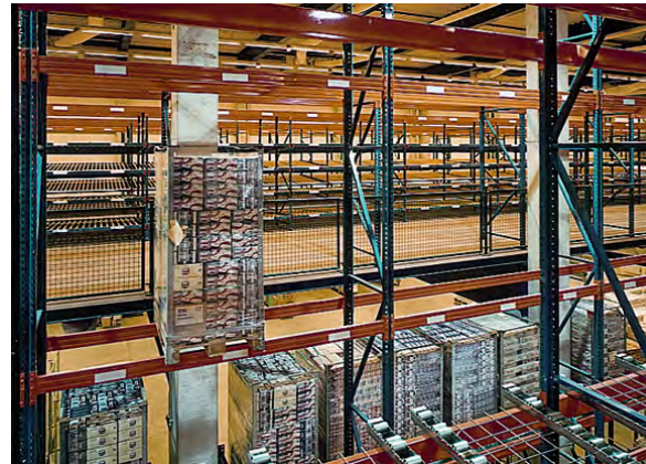
Warenverteilzentrum Delignit®-Industrieboden Eco Filmbeschichtet
